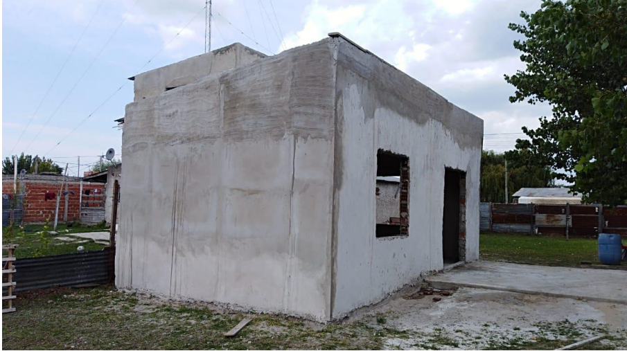
Imagen 5: Coordinación de obra en comedor Los Hornos (La Plata)
