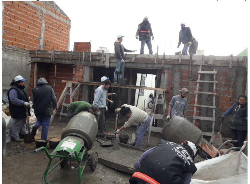
Imagen 6: Coordinación de obra en comedor Los Hornos (La Plata)
